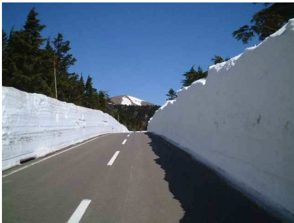
(磐梯吾妻スカイラインの雪の回廊)
